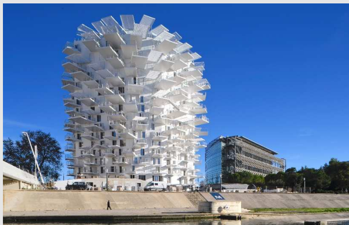
L'arbre Blanc, inauguré en 2019 est situé à côté de la bibliothèque de la Faculté d'Economie, Montpellier
